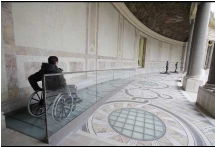
Rampe d'accès au péristyle du jardin
